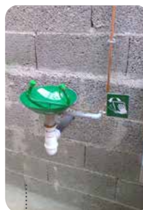
Installation d'un évier avec douchette et d'un rince-œil.
