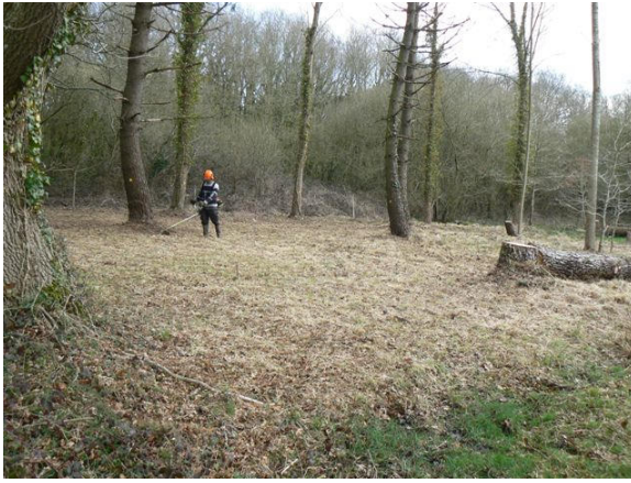
Photo 3 : chantier de gestion en mars 2010 à la Gassun (Herbignac). Fauche de la moliniaie (avec exportation) et abattage de certains arbres. Photo : Aurélia Lachaud – Bretagne Vivante.
