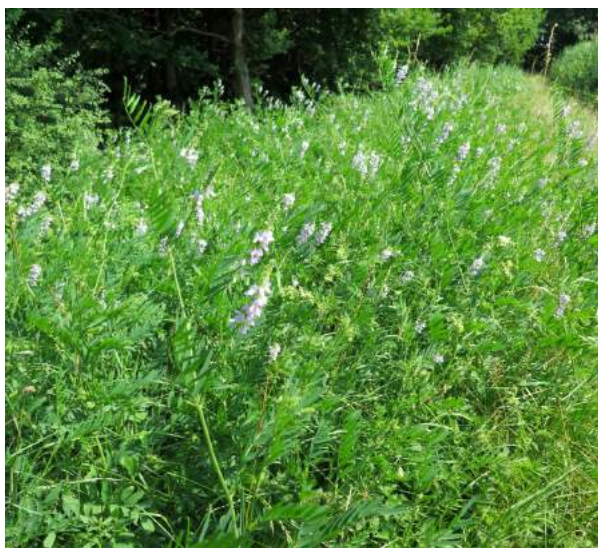
Figure n°8 - digue d'étang dominé par le galéga officinal (Foussemagne - 90).
