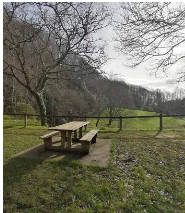
Installation de mobiliers : tables et bancs aux abords de la future zone chilienne.
