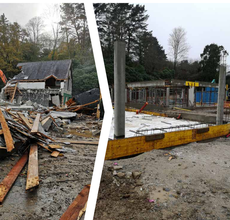
..... Déconstruction et construction du nouveau siège © Katia Goëttel (CBN de Brest)
