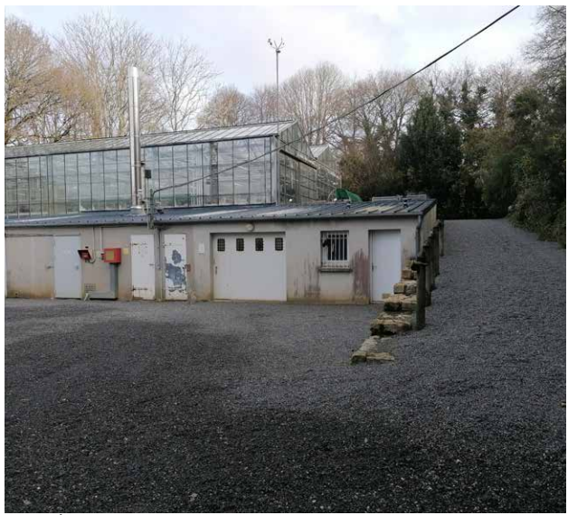
••• Entretien extérieur des espaces techniques : nettoyage et remise de gravillons
