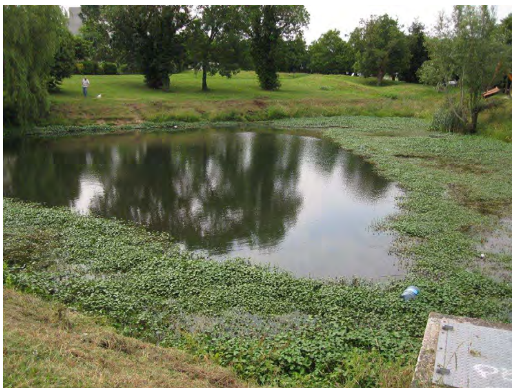
Photo 11 : Contamination du bassin amont sur le site de Saint-Herblain (état au 22/06/2010)
