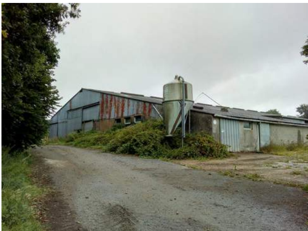
Vue depuis le sud-ouest
