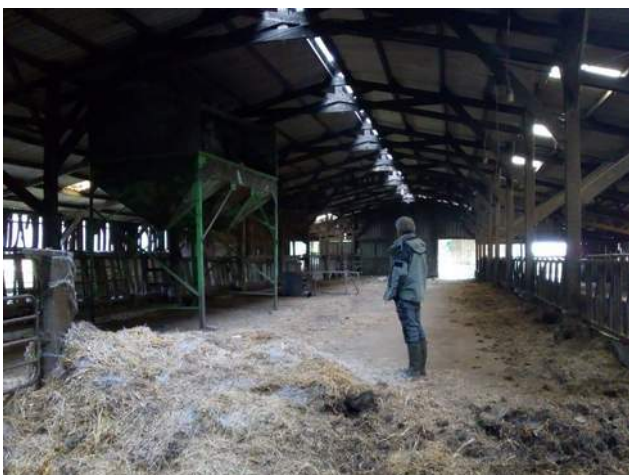
Vue de l'ouest vers l'est – travée centrale
