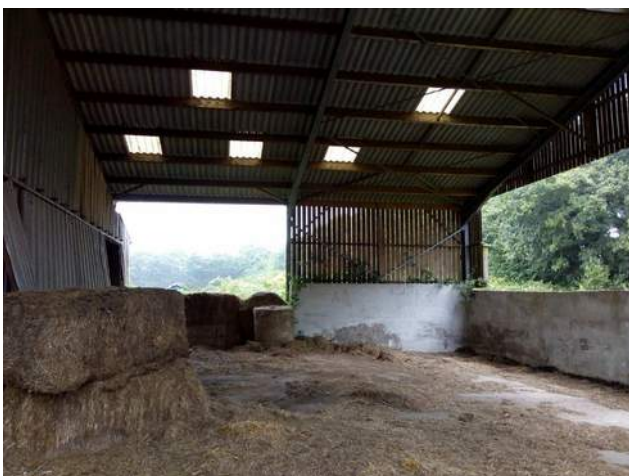
Vue sud de la fumière
