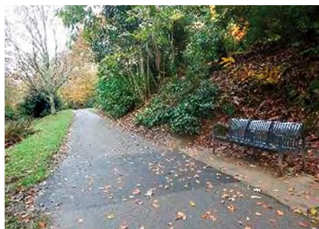
Suppression des contre allées en pavés et reprise en enrobé au niveau de l'allée principale
