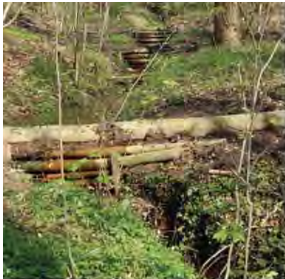
Mise en place de seuils dans un ruisseau forestier de la propriété départementale du Mont Noir. Photo B. Toussaint
