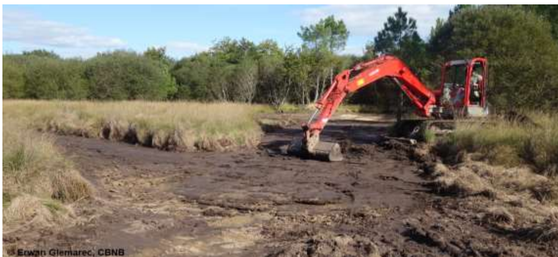
Chantier d'étrépage mécanique sur le site de Saint-Laurent : restauration de milieux pionniers, favorables à Eryngium viviparum .
