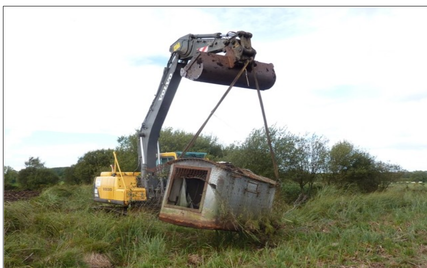
Déplacement à la pelle mécanique du gabion
