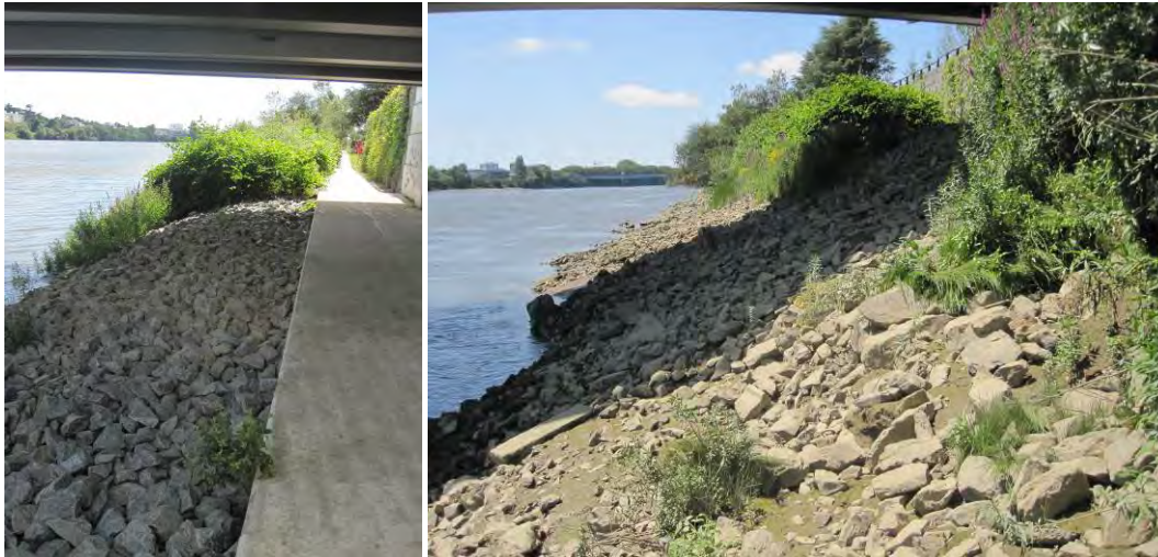
Vues vers l'aval (photos C. Mesnage, CBNB, le 16 juillet 2012)
