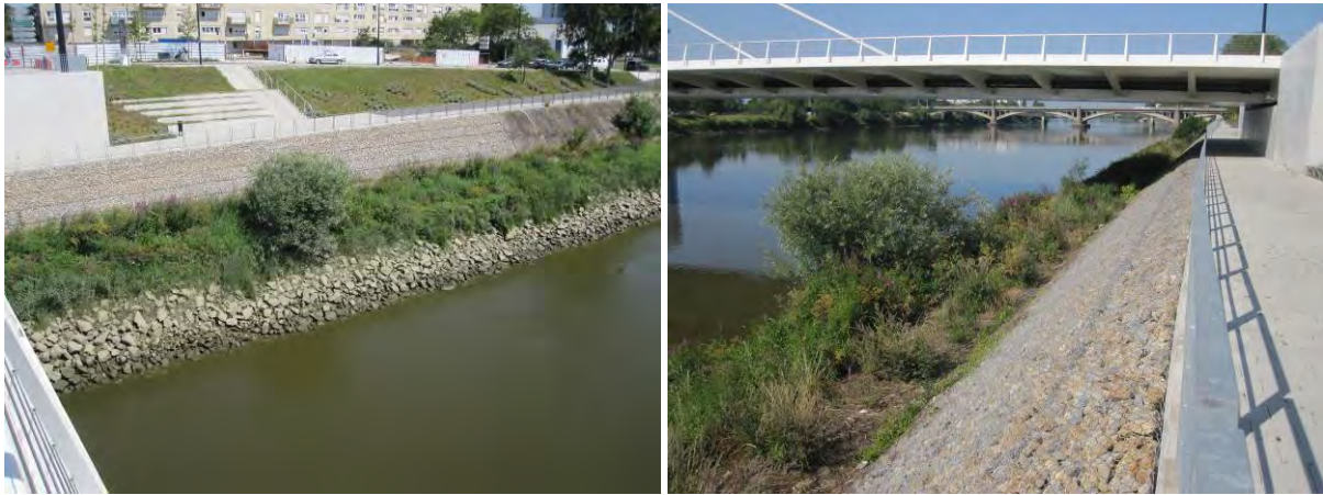
Vues du site à partir du pont et de l'amont
