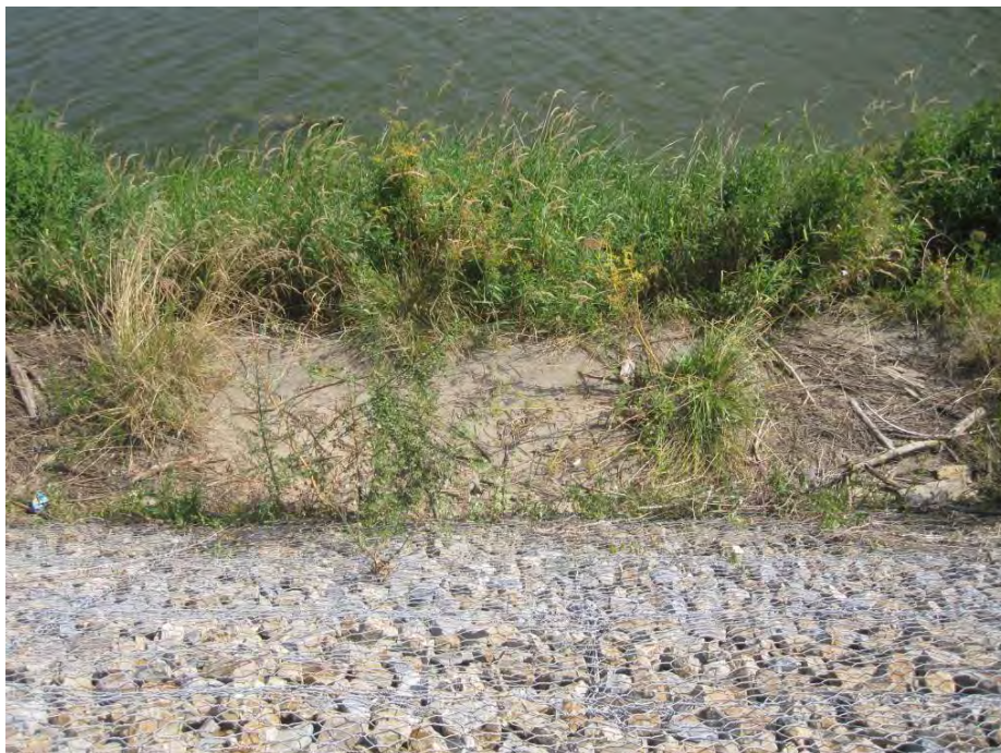
Vue sur la risberme : les 1ers pieds d'angélique des estuaires observés en 2012 n'ont pas été revus (en lien sans doute avec un problème de fixation du substrat sur le géotextile qui apparait nu sur la photo)
