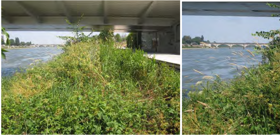
Vues du site à partir de l'aval
