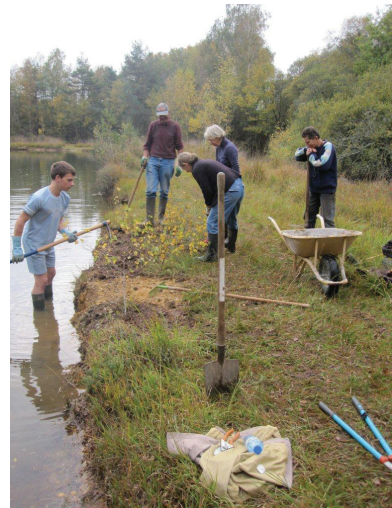
Chantier à Mespras, le 27 octobre 2011.
