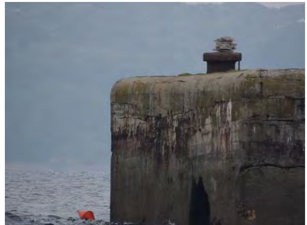
Construction de type « cairn » sur une des bittes d'amarrage (Photo : AL-PNRA)
