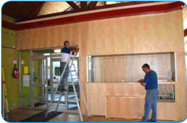
Rénovation de l'espace d'accueil du public
