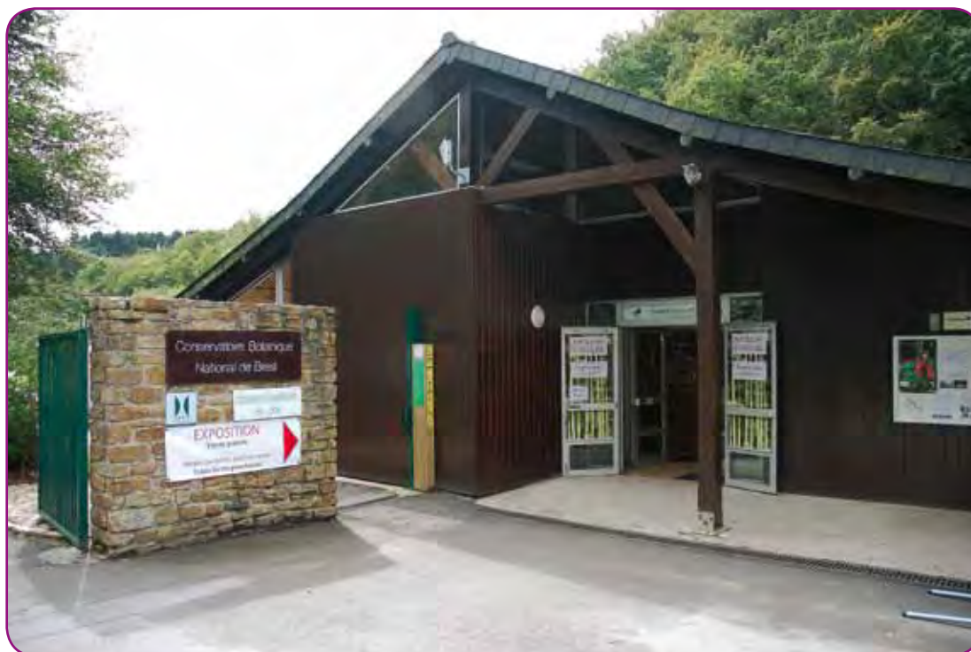
Pavillon d'accueil du Conservatoire botanique national de Brest
