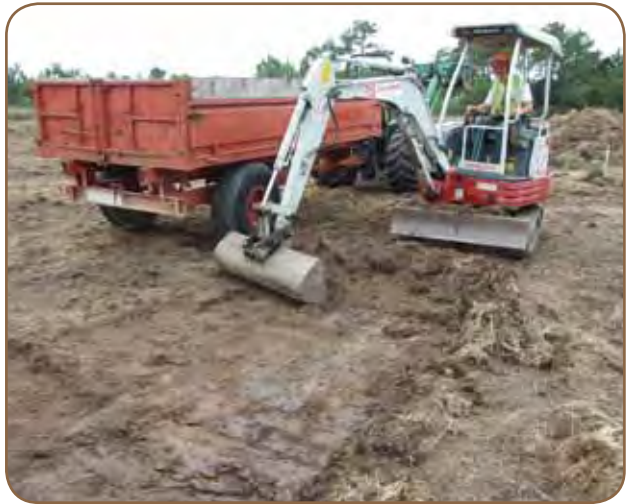
Travaux de décapage mécanique - Saint-Laurent (56)
