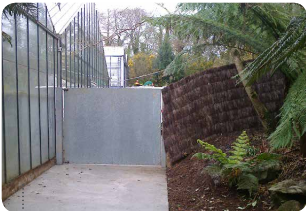
Mise en place d'un portail d'accès entre les serres pédagogiques et les serres techniques afin de faciliter l'entretien et le passage d'engins, sans passer par les entrées pour le public © Olivier Le Meur (Brest métropole)
