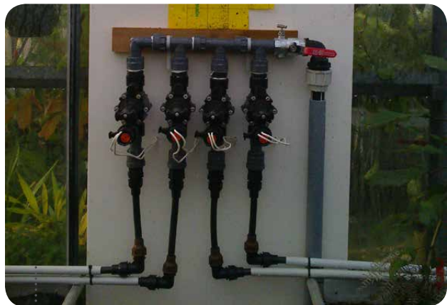
Installation d'un système d'arrosage automatique intégré sur une partie de la serre technique afin d'alléger le travail d'arrosage en semaine et weekend © Olivier Le Meur (Brest métropole)
