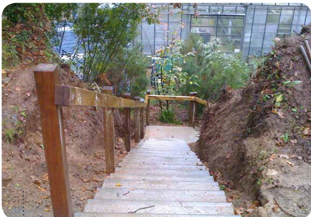
Création d'un escalier d'accès entre les serres techniques et la pépinière © Olivier Le Meur (Brest métropole)
