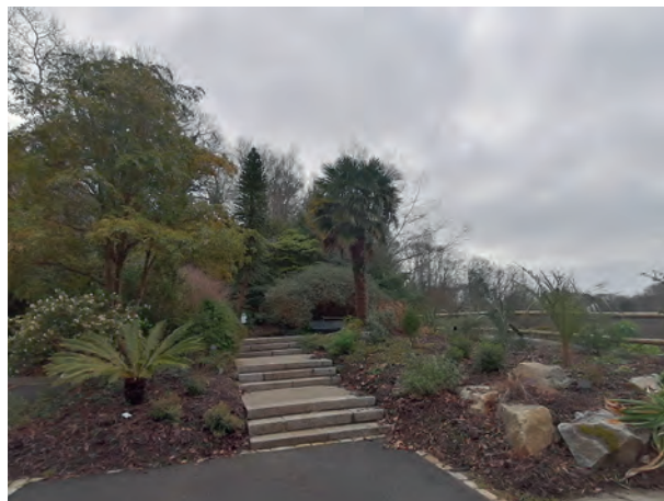
Réfection des escaliers du belvédère ; pose de lices de sécurité le long de la falaise
