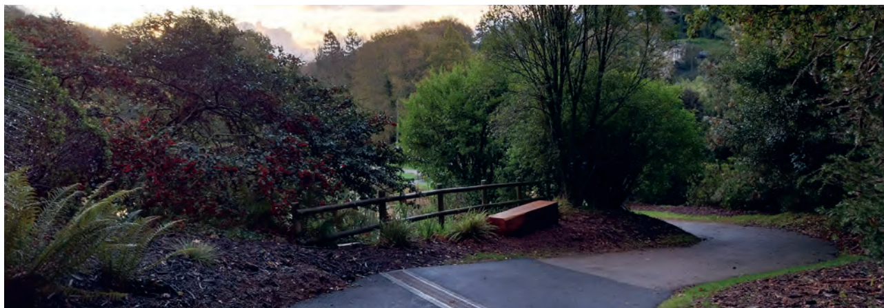
Réfection d'allées et pose de bancs
